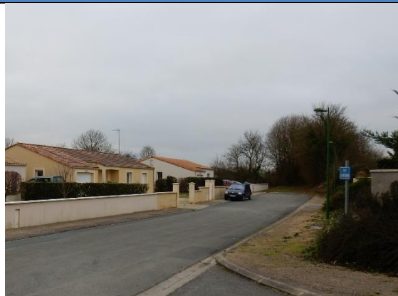
La voie d'accès Nord
