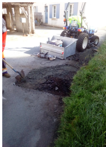
Réparation nids de poule rue de la Gravée
